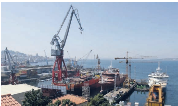
Grúas del Astillero Vulcano. El gigante de metal en Teis es testigo de entradas y salidas de buques. FARO DE VIGO
